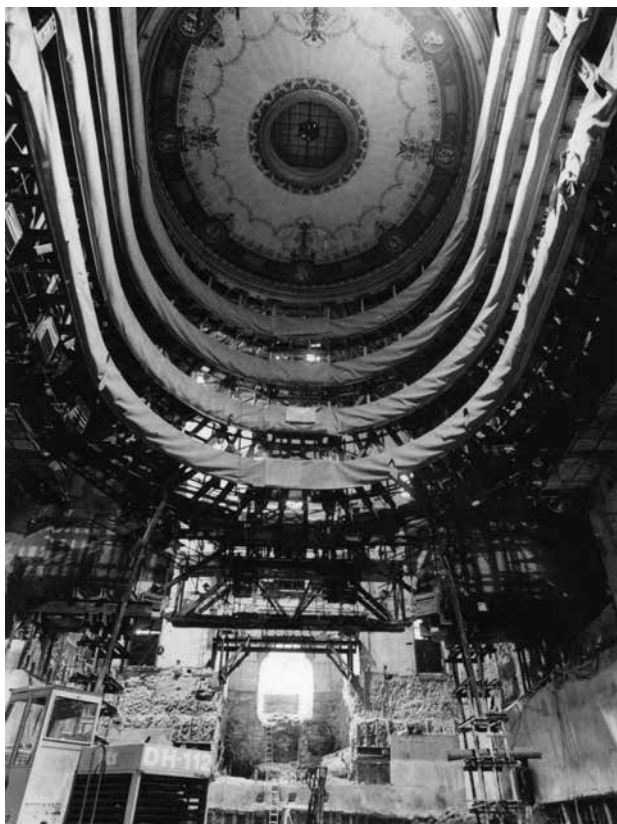
HLEDIŠTĚ STAVOVSKÉHO DIVADLA V DOBĚ REKONSTRUKCE
